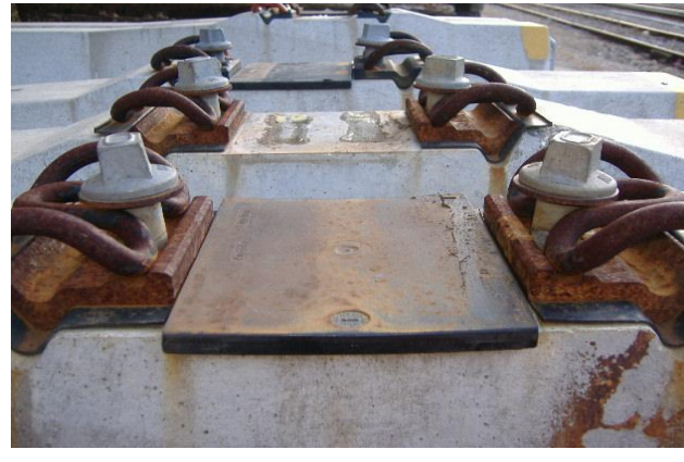
Sur béton (W, Ws)
