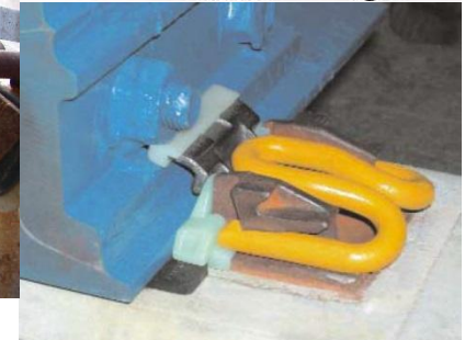
Elastique sans tirefond (attaches e-clip & FastClip)
